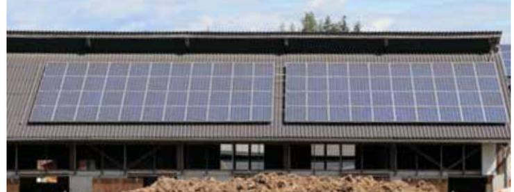
Für die Heutrocknung eignet sich die Kombination von Photovoltaikanlagen mit einer Dachwärmenutzung sehr gut.
