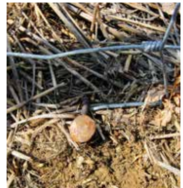
Bodenanker bilden einen Untergrabungsschutz.
