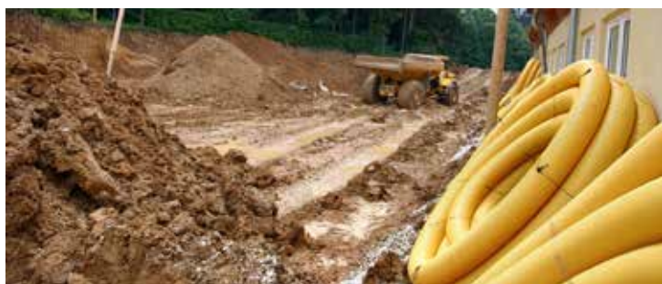
Beim Bau eines Wirtschaftsgebäudes muss jede Investition, beginnend beim Aushub, fristgerecht bestellt werden.
