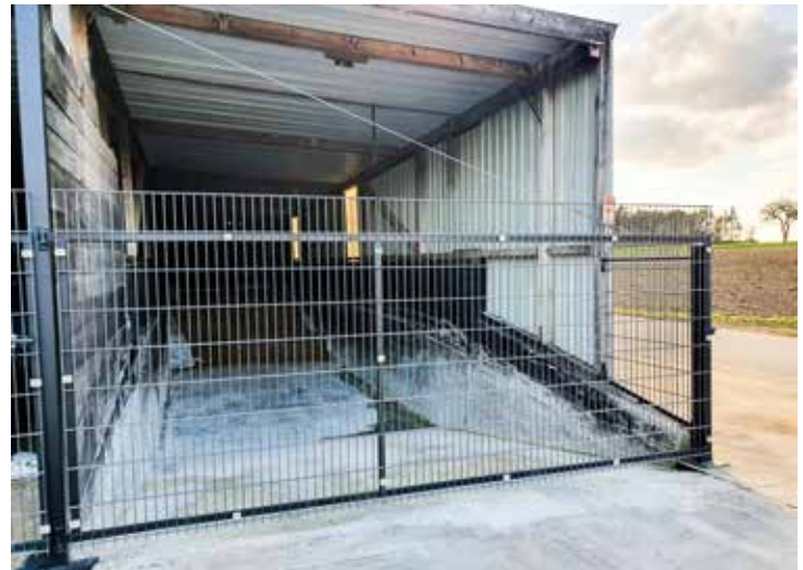
Die Silo-Entnahmestelle muss, zum Beispiel durch ein Tor, gegen Wildschweine abgesichert werden.
