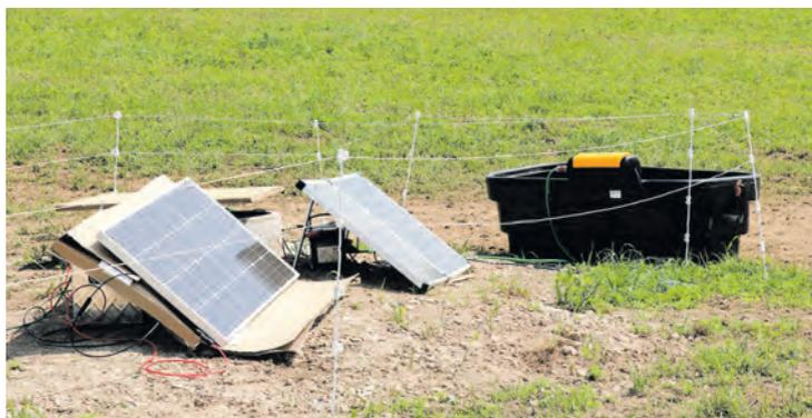
Die Photovoltaikmodule liefern Strom für den Zaun und die Wasserpumpe für die Schwimmertränke. Die untere Litze des Zaunes ist etwa 40 Zentimeter vom Boden entfernt, die zweite 25 Zentimeter oberhalb der unteren.
