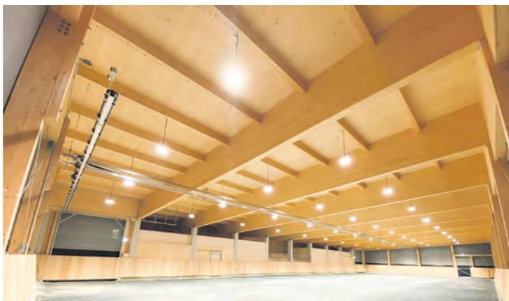
Durch seine Dimensionsstabilität und seine Struktureigenschaften ist das CLT-Massivholzprodukt gut für Böden, Wände und Dächer geeignet.
