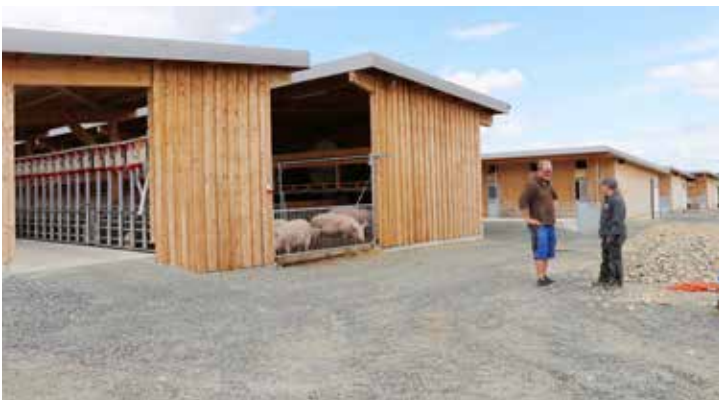
Westseitig von links nach rechts: Zweihäusiger Wartestall, ein Ferkelaufzuchtstall und zwei Abferkelställe,
