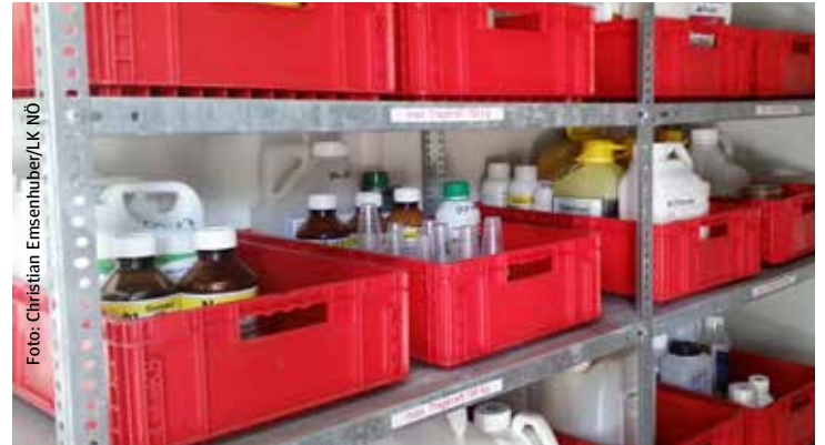
Die Auffangkapazität des „flüssigkeitsdichten, wannenförmigen Bodens“ sollte zumindest 20 bis 30 Prozent der Flüssigformulierungen betragen.
