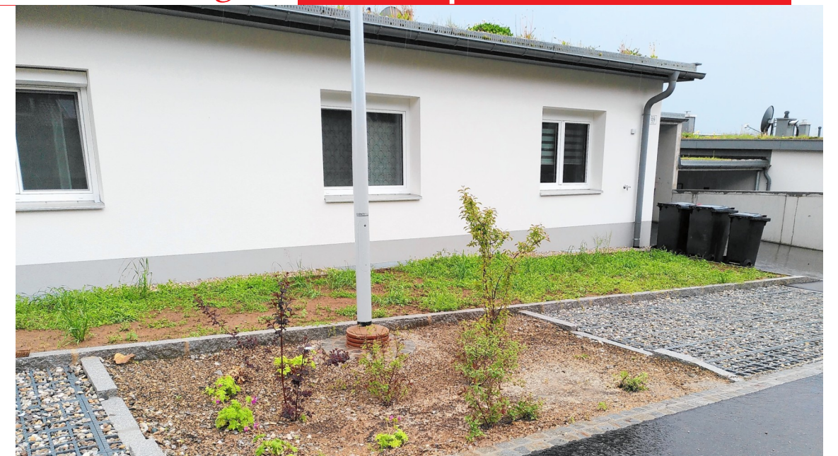
Die Doppelhäuser der Aufschließung Wachtberg in Allhartsberg wurden alle mit Gründach ausgeführt, in der Straße wurde Draingarden eingebaut, dadurch konnte man bei der Straße ganz auf den Regenwasserkanal verzichten. Es ist ein Beispiel von vielen, das Bodenversiegelung reduzieren soll. Foto: privat
