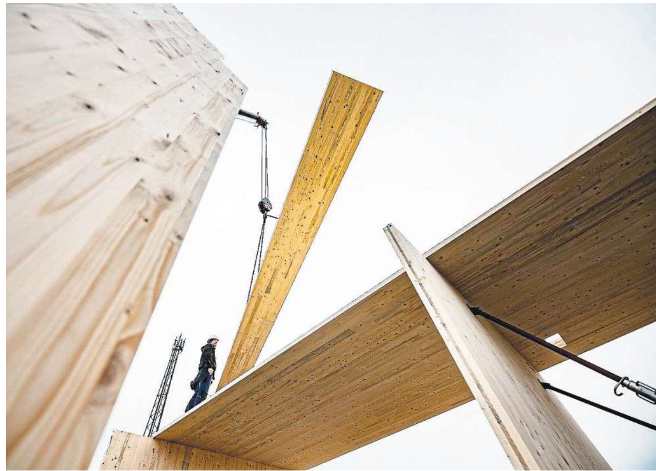
Die verleimten Massivholzwände und Decken werden im Werk vorgefertigt und mit einem Kran an der Baustelle versetzt
