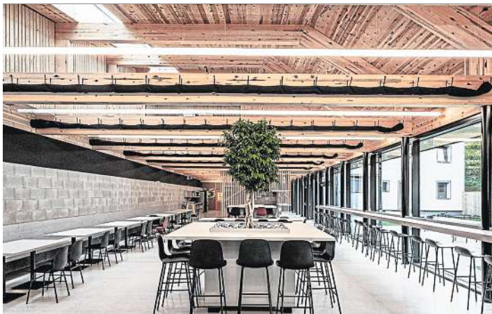
Kantine Starlinger, Weissenbach an der Triesting: Mit Kiefern aus den umliegenden Wäldern, im Sägewerk geschnitten und getrocknet, wurde der Ort für Mitarbeiter vom ortsansässigen Holzbauunternehmen gebaut.
