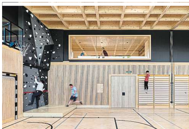
Turnsaal/Musikverein, Kirchberg am Wagram: Die unterschiedlichen Nutzungen wurden in dem Neubau vereint, die Lattenstruktur der Fassade wurde im Musiksaal weitergeführt und sorgt für gute Akustik.
