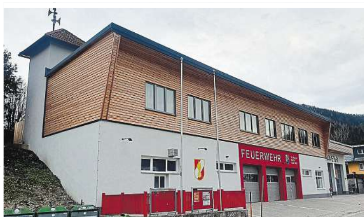
Publikumspreis für das Feuerwehrhaus St. Aegydt: Das bestehende Feuerwehrhaus wurde durch Zu- und Umbau zu einem zeitgemäßen Gebäude. Das neue Obergeschoß wurde zur Gänze in Holzbauweise errichtet.
