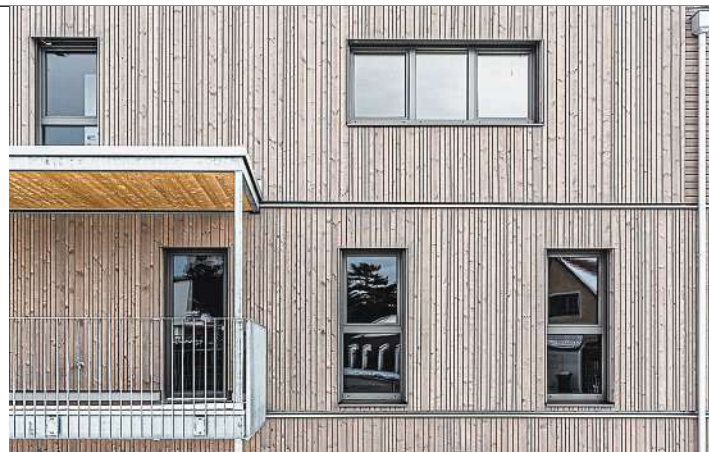
Wohnhausanlage am Gießhübl: Der Neubau mit 36 Wohnungen in Holzriegelbauweise ist hochwertig ausgestattet, mit sichtbaren Holzdecken, Holzböden und vorgelagerten Eigengärten, Loggien und Terrassen.
