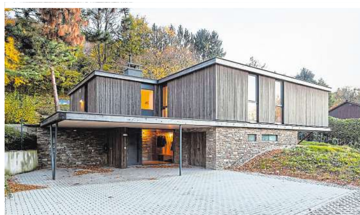
Case Study House in Zeiselmauer: Die Natursteinmauer des Bestands wurde im Zuge des Umbaus erhalten. Die Lärchenfassade wurde mit Eisensalzen behandelt, um eine schöne grau-braune Färbung zu erzielen.
