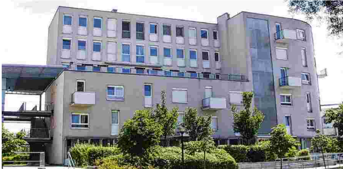
Die Zentrale der Wohnbaugenossenschaft Eigenheim Linz in der Schörgenhubstraße
