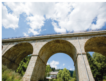
Das Steinhaus-Viadukt im Gemeindegebiet von Spital.
