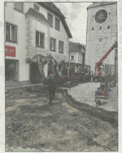
Am Montag begannen die Sanierungsarbeiten.
