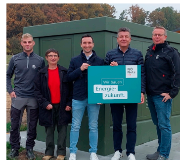
Bei einer der neuen Trafostationen in Schellings
