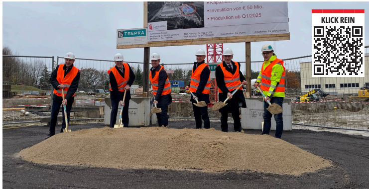
Erfolgreicher Spatenstich für die Erweiterung des Walzwerks bei Constantia Teich.
