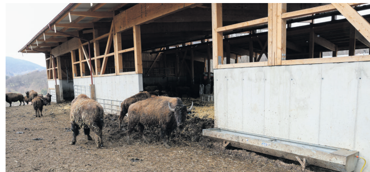
Der Übergang vom Stall ins Freigelände ist mit Paddockplatten befestigt, die in einem Kiesbett liegen. Die Tränken sind verzinkt und bieten den Tieren eine offene Wasserfläche. Die Öffnungen ins Freie sind je 5,5 Meter breit.
