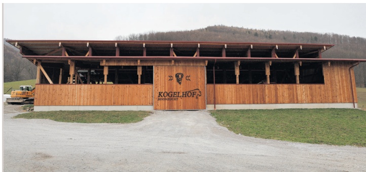
Der Stall ist auf den Längsseiten – Nord und Süd – offen, auch auf der Ostseite ist er nur teilweise geschlossen. In Richtung Hofladen versperrt eine halbhohle Holzverschalung die Sicht der Tiere zu den Menschen.
