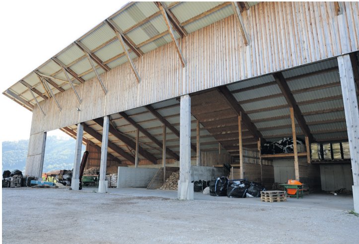
Mit der Halle für die Produktion und Vermarktung von Brennholz über den Verein „Ofenholz“ hat Thomas Zöchling auf seinem Hof ein neues Kapitel aufgeschlagen. Am Dach befindet sich eine PV-Anlage mit 200 Kilowattpeak.
