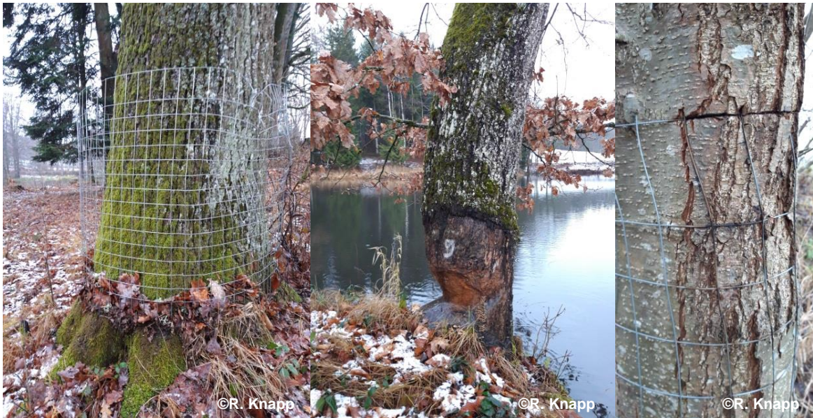
FALSCH: Einzelbaumschutz mit frei zugänglichem Wurzelanlauf (Links) und benagte Roteiche (Mitte) bei der ein Einzelbaumschutz nun nicht mehr sinnvoll ist und zu spät kommt. Zu eng und damit falsch angebrachter und in Folge davon eingewachsener Einzelbaumschutz (Rechts)
