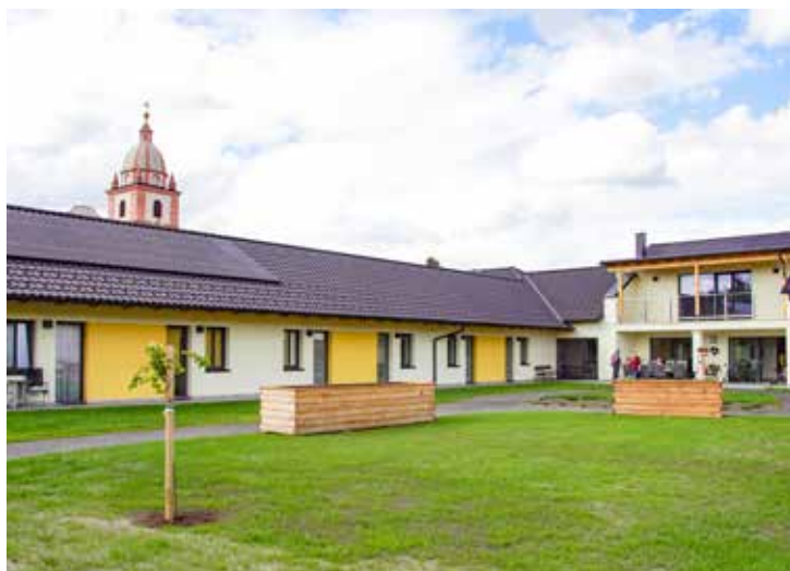
Die gartenseitigen Zimmer haben direkten Zugang zum frisch angelegten barrierefreien Garten, in dem auch vier Hochbeete stehen.
