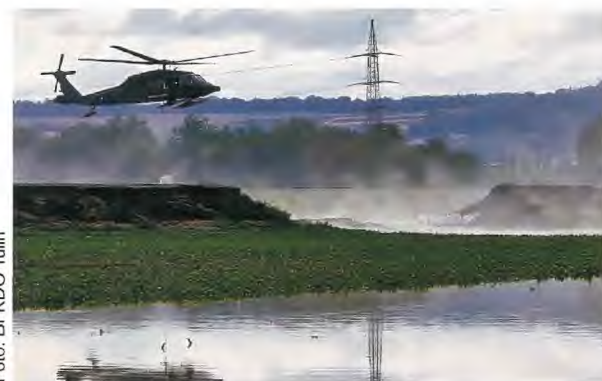
◁ An der Perschling konnte ein Dammbruch mithilfe von Hubschraubern und Bigbags geschlossen werden.
