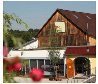
Gemeindebürger arbeiten an der Zukunft des Hauses mit. Foto: Moststraße
