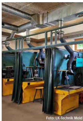
Foto: LK-Technik Mold
