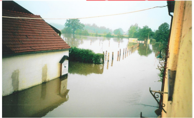
▲ Eine Nach- bzw. Neuberechnung der Freiborde an der Hochwasserschutz-Dammanlage soll Hochwässer vermeiden. Im Archibild das Hochwasser vom Jahr 2002 in Seebarn.
