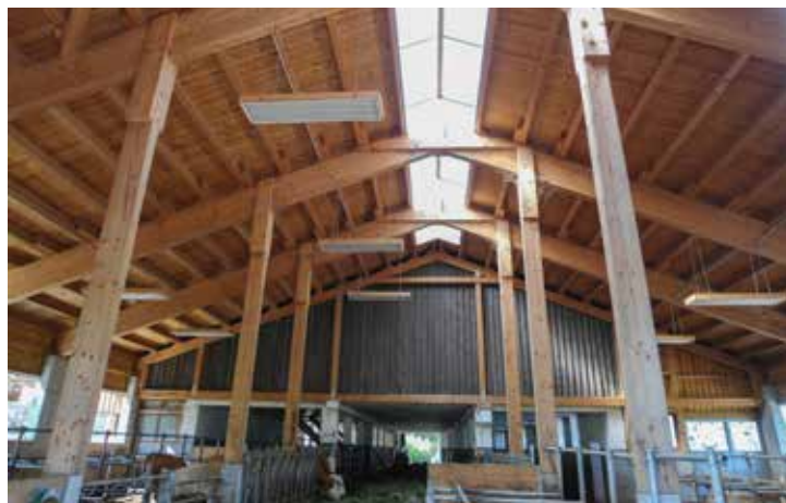
Stallgebäude in Reinsberg
