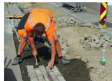
Baustellen und Sanierungsarbeiten sorgen für Sperren. Foto: NÖ Straßendienst
